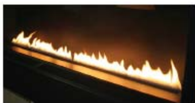
Schéma 46 – Apparence de la flamme du brûleur
