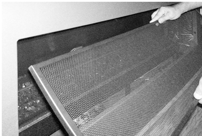
ÉTAPE 2: Angle de l'écran de sécurité, comme indiqué sur l'image et soigneusement mettre en l'ouverture du foyer.
