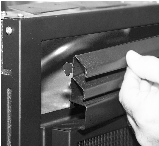
Etape 6 : Maintenez le haut ailette avec deux mains. Repérez les crochets verticaux des deux côtés des buses et les plaques de montage en forme de L dans la cheminée. Positionner le déflecteur dans la cheminée ouverture pour l'accrocher sur les supports de montage.
