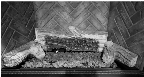
Schéma 38 - Placer bûche arrière (# 1,2,3)
