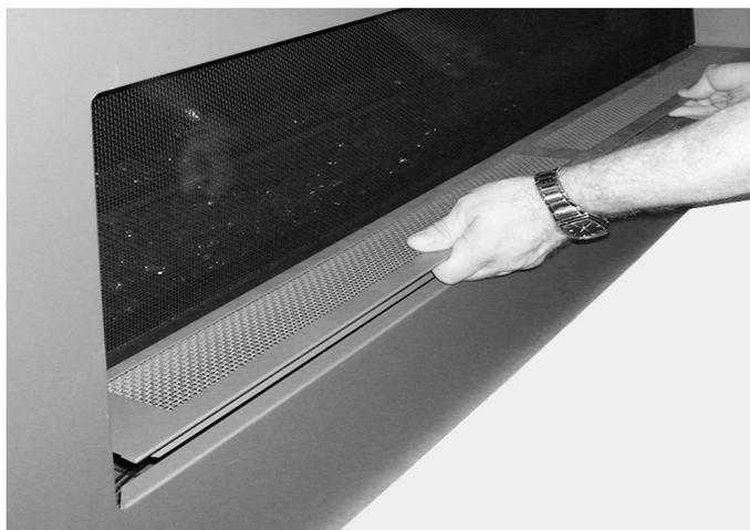
STEP 7: Angle du Groupe Air avant sous le bas de l'écran. Supporter le panneau Air sur les côtés gauche et droit panneaux.
