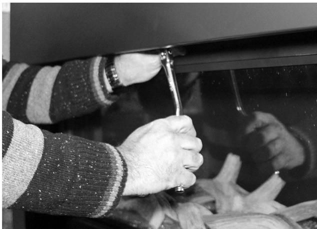
STEP 5: Soulevez délicatement l'ensemble de porte en verre sur le canal inférieur et retirez en inclinant le cadre vers le bas vers la gauche.
